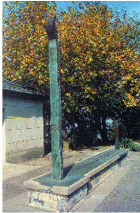
圖 1-4 置於北京古觀象台的圭表，建於明正統二年至七年（西元1437～1442年），利用日影長短的規律變化來測定時刻、方向與節氣。
