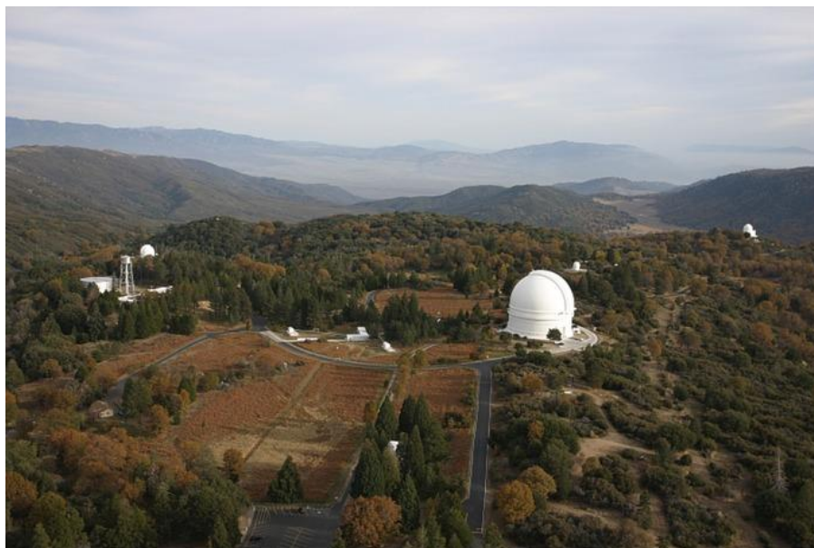
圖 5 —— 美國加州帕羅瑪山天文台三座望遠鏡，口徑分別為 48 吋（1.2 米）、60 吋（1.5 米），以及 200 吋（5.1 米），共同執行 ZTF。由 48 吋廣角望遠鏡巡天觀測，所發現的瞬變現象，立即由 60 吋望遠鏡取得多波段影像，判定天體性質，對於極有價值的現象，則利用大口徑的 200 吋望遠鏡取得光譜，進一步述性。
